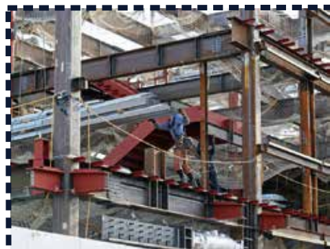
高所作業現場
