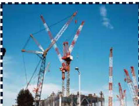
クレーン作業現場
