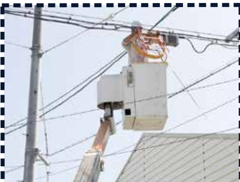
電気や電話・LANの配線設置工事
